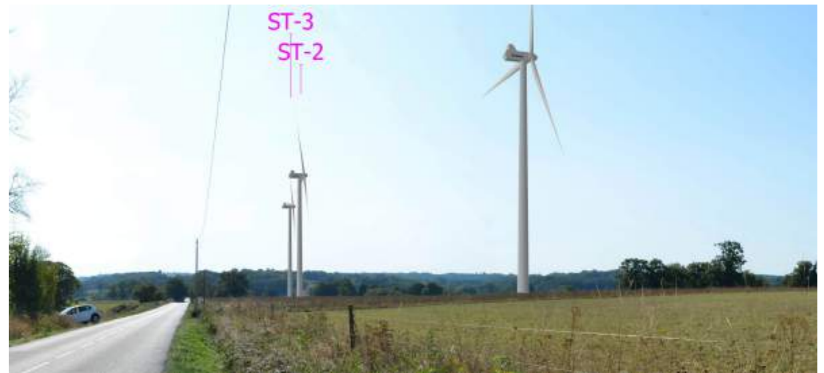
Photographie 237 : Photomontage 19, vue ouverte sur les trois éoliennes le long de la route D912.
